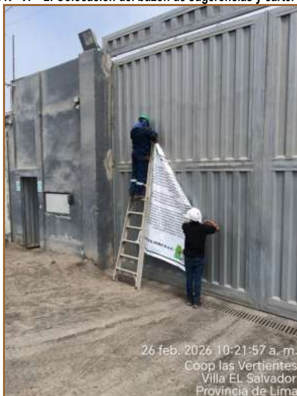
Fotografía N° VI - 2: Colocación del buzón de sugerencias y cartel informativo
